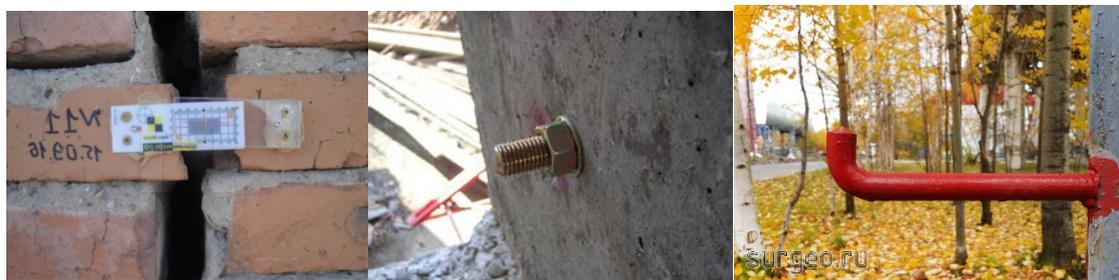
**Рисунок 3 - Деформационный знак (поверхностный и стеной)**
